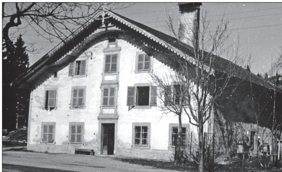
Fig. 16. Façade principale de la maison paysanne de Carouge, avant 1967 (ASPAM)
