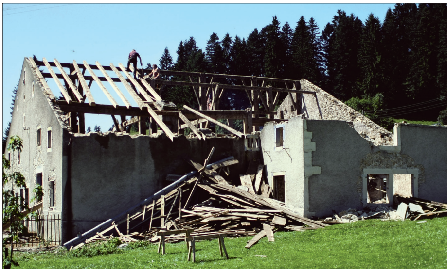
Fig. 37. Démontage de la ferme de la Recorne 35, vers 1983 (ASPAM)
