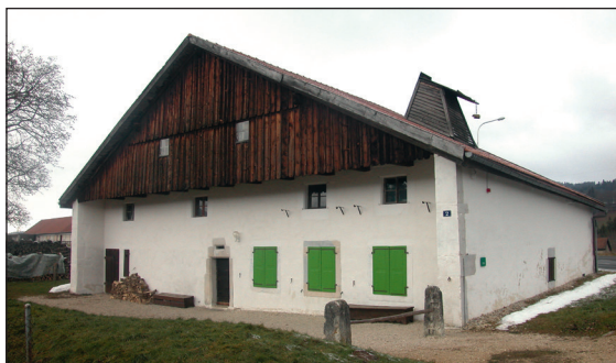
Fig. 34. Façade sud de la ferme de la Combeta, 2006 (OPAN)
