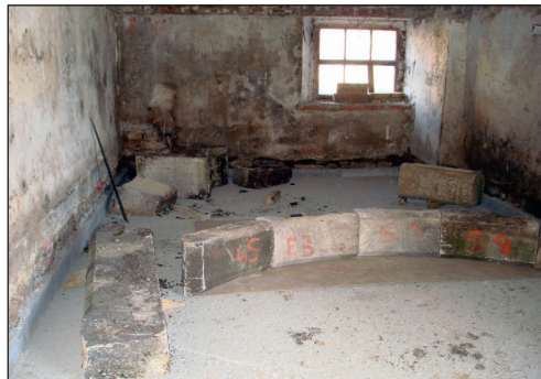
Fig. 21-23. Cuisine voûtée de la Maltournée, peu après l'incendie de 1988 (ASPAM), en cours de remontage et remontée dans la maison d'Eplatures-Grise 16 en 2008 (OPAN)
