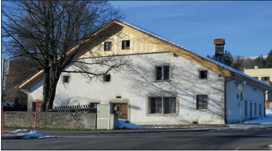
Fig. 24. Façade sud de la maison Droz-dit-Busset, 2013 (OPAN)
