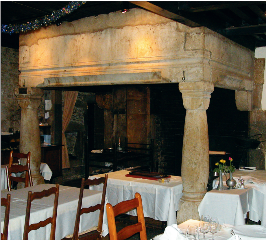
Fig. 14. Cheminée de l'Écouâne dans le restaurant de La Cheminée, 2006 (OPAN)
