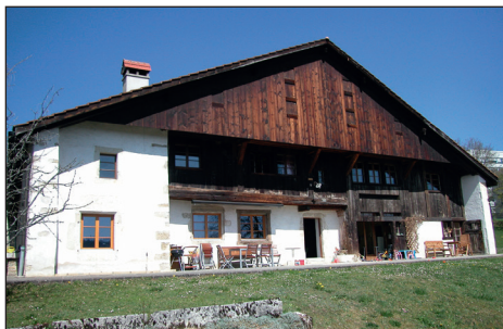
Fig. 8. Façade sud-est de la ferme des Arbres, 2010 (OPAN)
