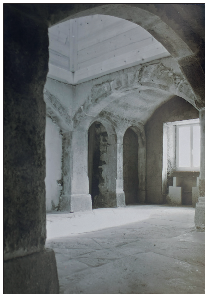
Fig. 21-23. Cuisine voûtée de la Maltournée, peu après l'incendie de 1988 (ASPAM), en cours de remontage et remontée dans la maison d'Eplatures-Grise 16 en 2008 (OPAN)
