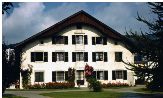
Fig. 15. Façade sud de la maison de retraite de Bonne-Fontaine, édifiée sur les plans et avec les éléments de celle de la ferme de Carouge, après 1972 (ASPAM)
