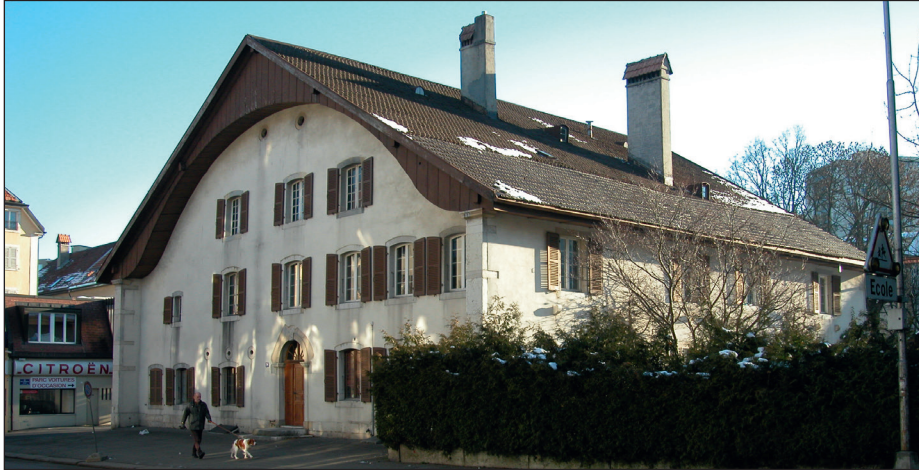
Fig. 28. Maison de la rue Fritz-Couvoisier 30, 2006 (OPAN)
